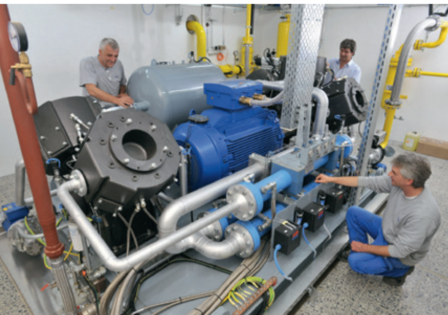
Abb. 4: Moderne Einspeiseanlagen arbeiten mittlerweile mit sogenannten Tandemverdichtern, die auf einem Chassis und mit einem Antrieb mehrere Verdichterstufen hintereinander vereinen.
